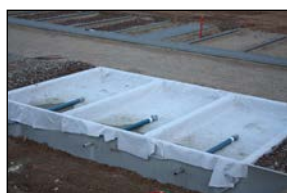
Installation du drain de sécurité permettant de mesurer l'écoulement de l'eau.
