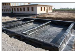
Mise en place d'une bâche type EPDM pour étancher les trois places de parking.
