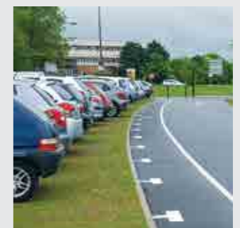
MARQUAGE EN T - PEINTURE SUR ENROBÉ
